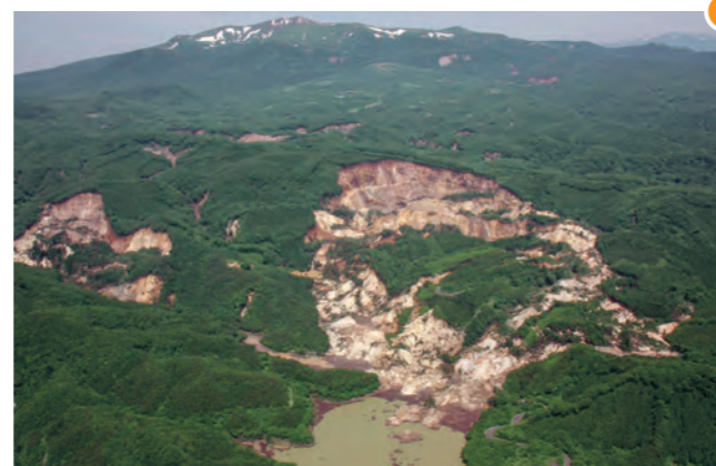
地すべり全景(荒砥沢ダム上空から栗駒山方面を望む)
